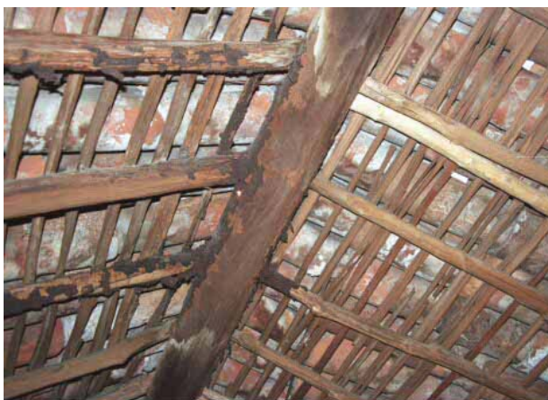
Fig.4 vista parcial da estrutura secundária da cobertura da Igreja de N. Sª. das Fronteiras/Recife (caibro roliço e ripa de imbiriba). Foto da autora. Setembro/2002.
