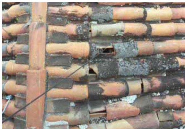
Fig.7 Aspecto geral do recobrimento da Igreja da Matriz de Santo Antônio/Recife. Foto da autora. Setembro/2002.
